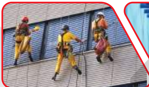
PEMBERSIHAN & PENGECATAN GEDUNG
